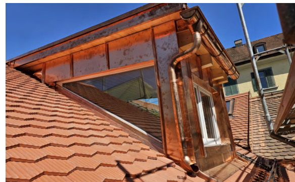
Energetische Dachsanierung, Zürich mit Biberschwanziegel
