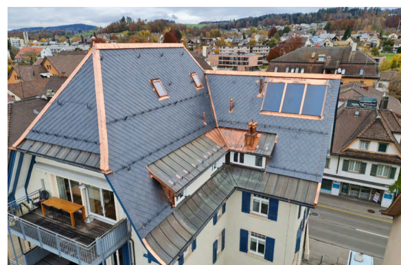
Energetische Dachsanierung, Pfäffikon ZH mit Naturschiefer
