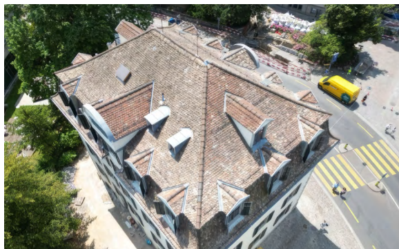
Heimatschutz Dachsanierung, Haus zum Kiel, Zürich mit handgemachten antiken Biberschwanziegeln
