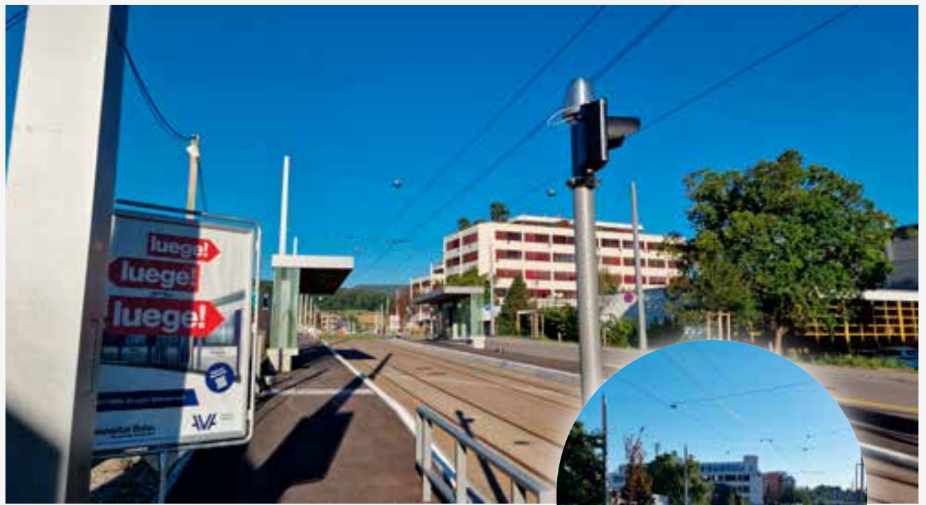
Die Limmattalbahn-Haltestelle «Kantallee» ist bereit für die Inbetriebnahme.
