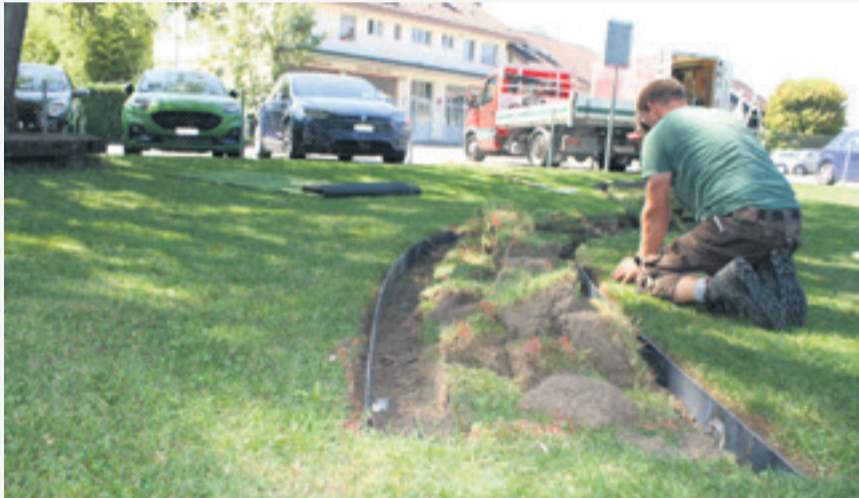
Anlegen des Barfusspfades.
